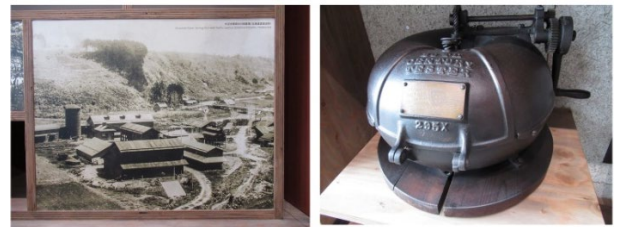
図14 大正中期頃の川田農場の写真。右はバブコック法で乳脂肪を測定する際に使用する遠心機道の駅なないろ・ななえの展示より
