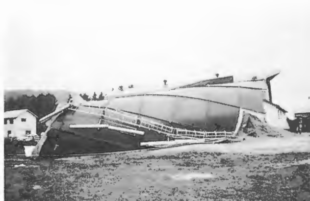
図 15. 大量の高水分材料を短時間に詰めこんだため FRPサイロが倒壊した。(西部 原図)
