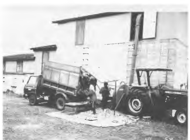
図12. ブローアを使い角型サイロに牧草を詰め込む
